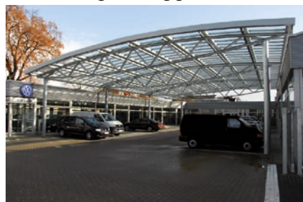
Licht und leicht: Großflächenüberdachungen aus Acrylglas wirken selbst bei großen Spannweiten noch grazil. Die hohe Lichtdurchlässigkeit hilft zudem, Stromkosten zu sparen.
