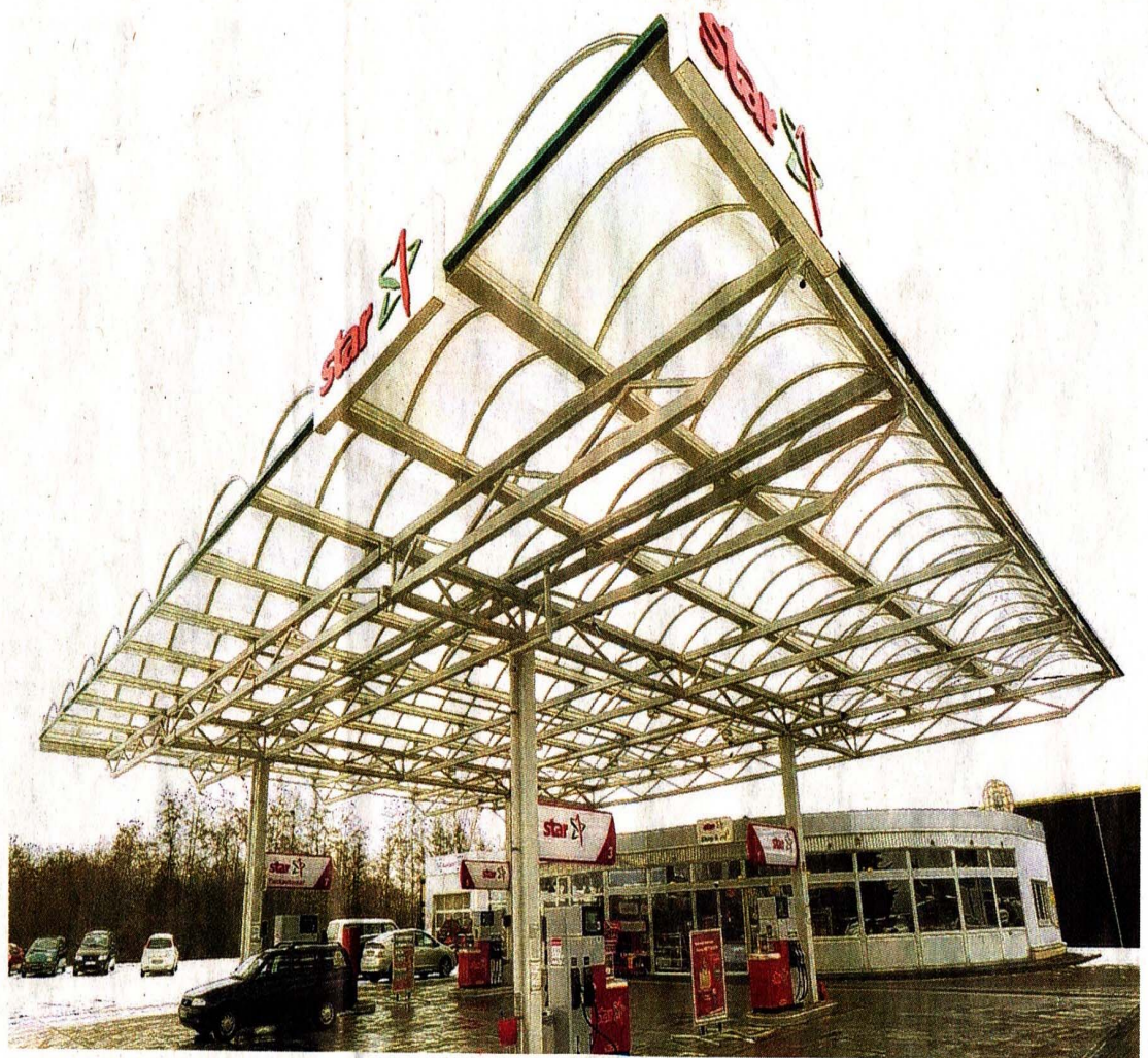
Die Konstruktion für diese Freiflächen-Überdachung der star -Tankstelle im Hasselter Gewerbegebiet hat die Firma roda GmbH aus Kleve entworfen.
