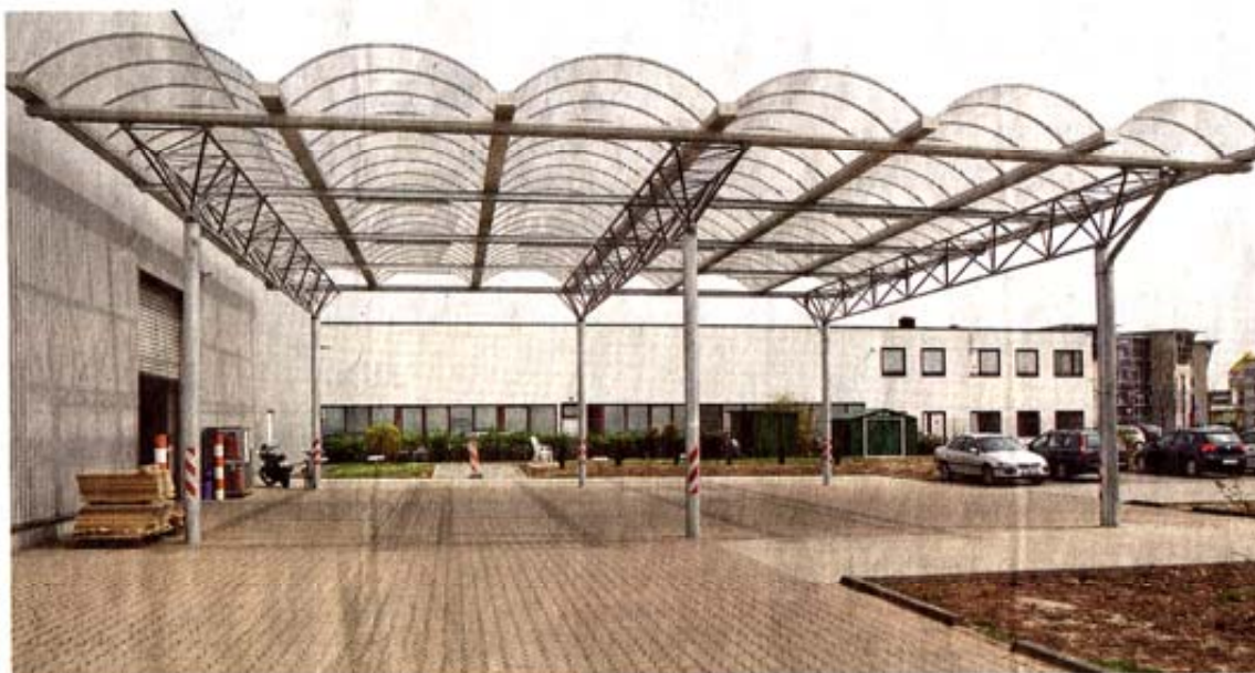
Überdachungen aus Acrylglas: Mit verhältnismäßig unaufwendigen Konstruktionen lassen sich große Spannweiten überbrücken.
