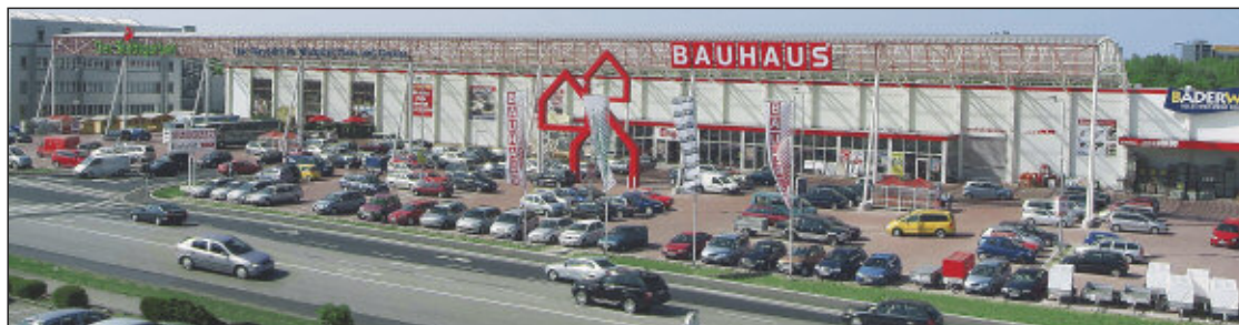
Eine großzügige Außenüberdachung: Bauhaus-Markt in Linz, Österreich.
