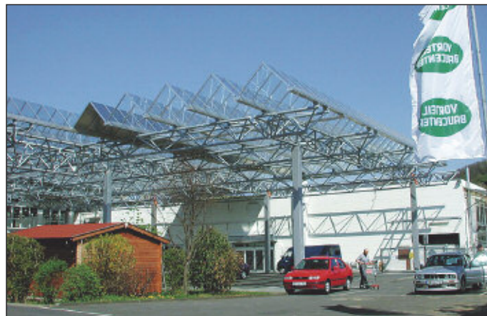
Findet ein positives Kundenecho: Die Überdachung am Vorteil-Baucenter (i&M), Unkel.
