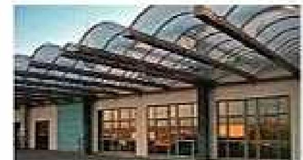
Unter leichtfüll Konstruktionen aus Acrylgas und Aluminium bieten die gleiche Lichtdurchlässigkeit wie Echtglas, allerdings nur ein Fünftel dessen. Dadurch lassen sich bis zu 15 Meter ohne störende Pfeiler überbrücken.
